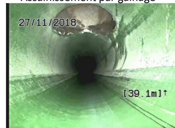
Assainissement par gainage
