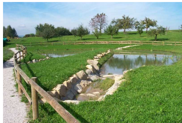
Assainissement par bassin de rétention
